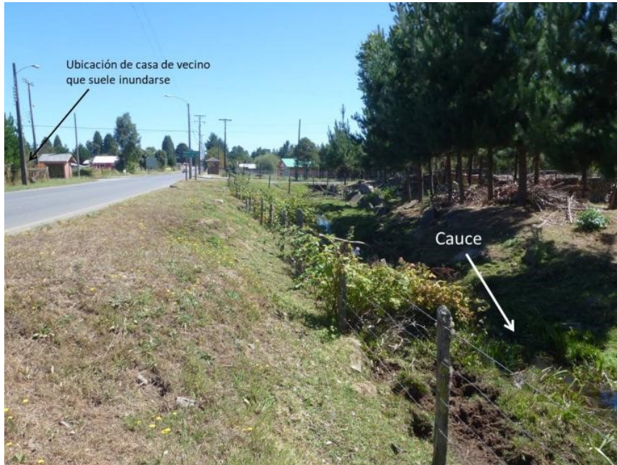
FIGURA N° 4-3 Esquina referida en el Punto F-02 del catastro de inundaciones detallado en el CUADRO N° 4-1.
